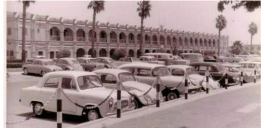
شکل ۱- قدیمی‌ترین ساختمان اداری در آبادان
