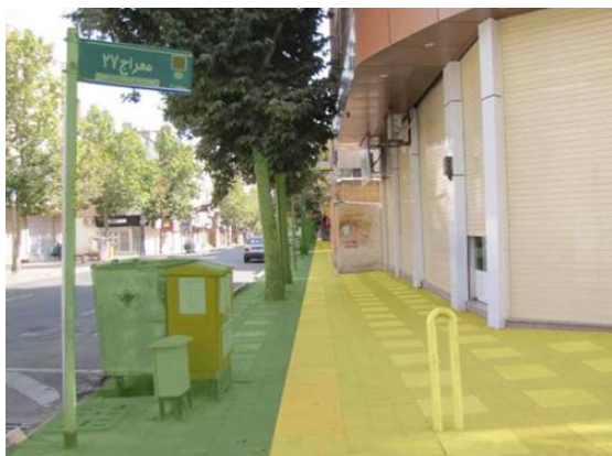
شکل ۴: مسدود شدن و نامناسب بودن مصالح کف مسیر ویژه نابینایان و عرض کم پیاده رو در بخش‌هایی از مسیر، نگارندگان
