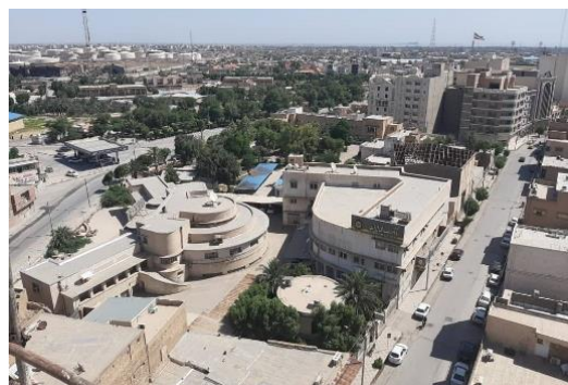
شکل ۲- ساختمان بانک ملی مرکزی آبادان
