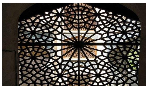
شکل ۹: پنجره‌های مشبک در خانه‌های سنتی اقلیم گرم و خشک ( http://persiansinla.com )
